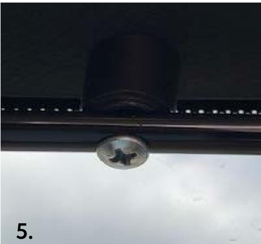
Lösen Sie die Schraube mit einem Kreuzschlitz-Schraubenzieher (Bild 5).
