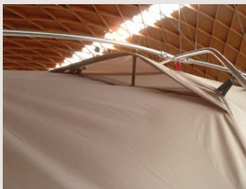
verschiebbare Belüftungshutze closeable ventilation
